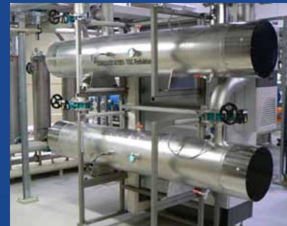
MicroUV® NT- Reaktoren zum TOC-Polishing von UPW.
