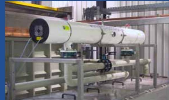
MicroUV®-Reaktoren zur Desinfektion.
