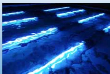
Lagerbehälter für Wasser: das Wasser fließt in den Behälter und wird desinfiziert. Gleichzeitig werden die Behälterwände unterhalb und oberhalb der Wasseroberfläche permanent mit einer geringen UV-Dosis steril gehalten. Die Luft zum Ausgleich von Füllstandsschwankungen wird ebenfalls sterilisiert. Damit ist sichergestellt, dass nur desinfiziertes Wasser aus dem Behälter entnommen wird.
