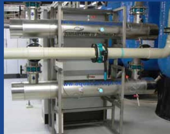
MicroUV® NT - Reaktoren zur Desinfektion von Trinkwasser.
