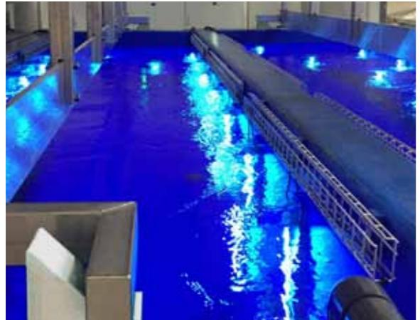
MicroSPEAR® wird so montiert, dass das System vollständig mit mindestens 1m Wasser überdeckt ist, so dass die Bestrahlung hauptsächlich im Wasserraum wirkt.
