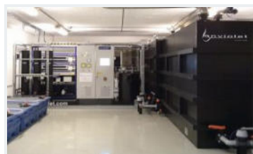
Die selektive UV-Oxidation kommt beispielsweise bei der Behandlung von mit hoch potenten Wirkstoffen verunreinigtem Abwasser zum Einsatz. (Bild: Enviolet)
