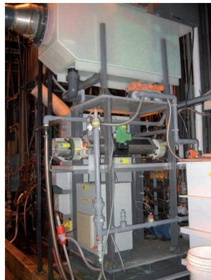
Erste an Harley Davidson gelieferte Anlage zum Recycling von mikroporösem Nickelbad (9,5 m 3 )
