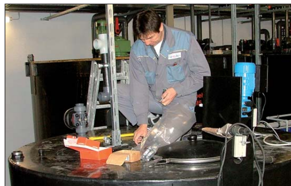
Rund einen Monat dauerte der Auf- und Einbau der neuen Anlage, die zudem in die vorhandene Steuerungstechnik der ZEA Iserlohn eingebunden werden musste.
