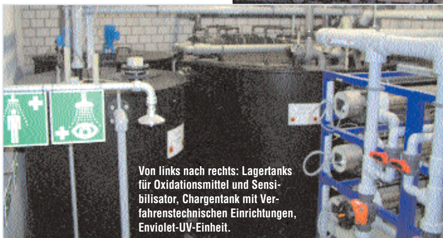
Enviolet-UV-Oxidationsanlage und vollautomatische Anlagensteuerung mit ZLT-Anbindung.
