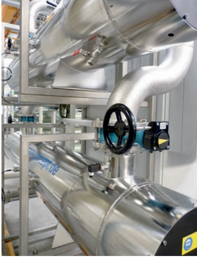
Abb. 1: TOC-Polisher als abschließende Stufe bei der Herstellung von hochreinem Wasser
