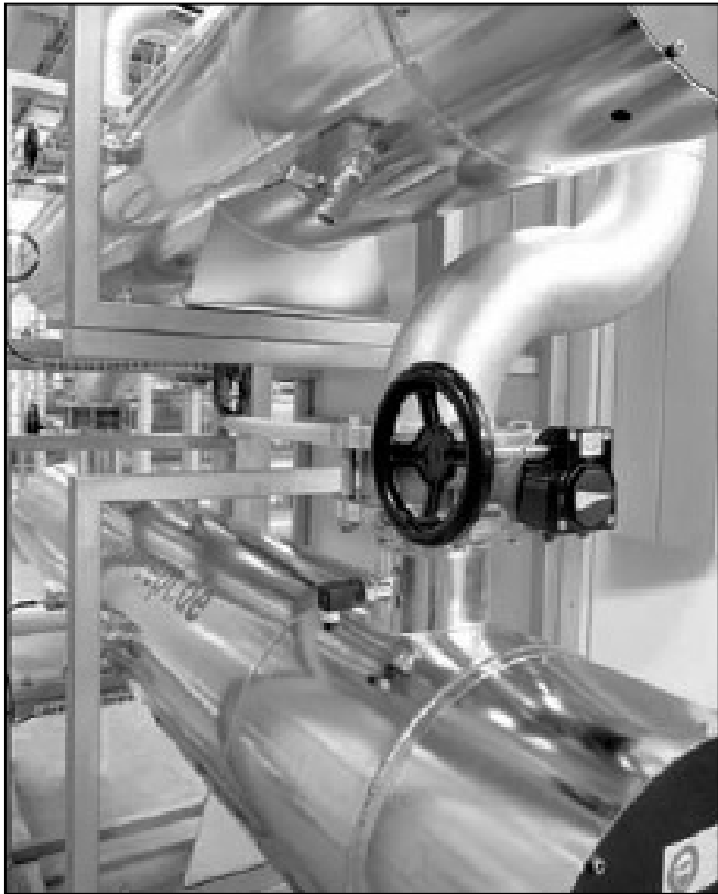
Fig.1 - TOC-Polisher: fase finale di un processo per acqua ultrapura
