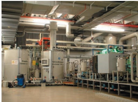
Abb. 5: (von links): Lagertank für fertiges Produkt, Behandlungstank mit verfahrenstechnischen Einrichtungen und integriertem Verdunster, Dosiereinrichtung und Enviolet ® -UV-Einheit; Die Steuerung mit Visualisierung liegt außerhalb des Verfahrensbereichs
