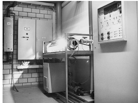
Abb. 2: Enviolet ® -UV-Reaktor der Cyanidentgiftung bei Fubag (Photo: Werkphoto Fubag)
