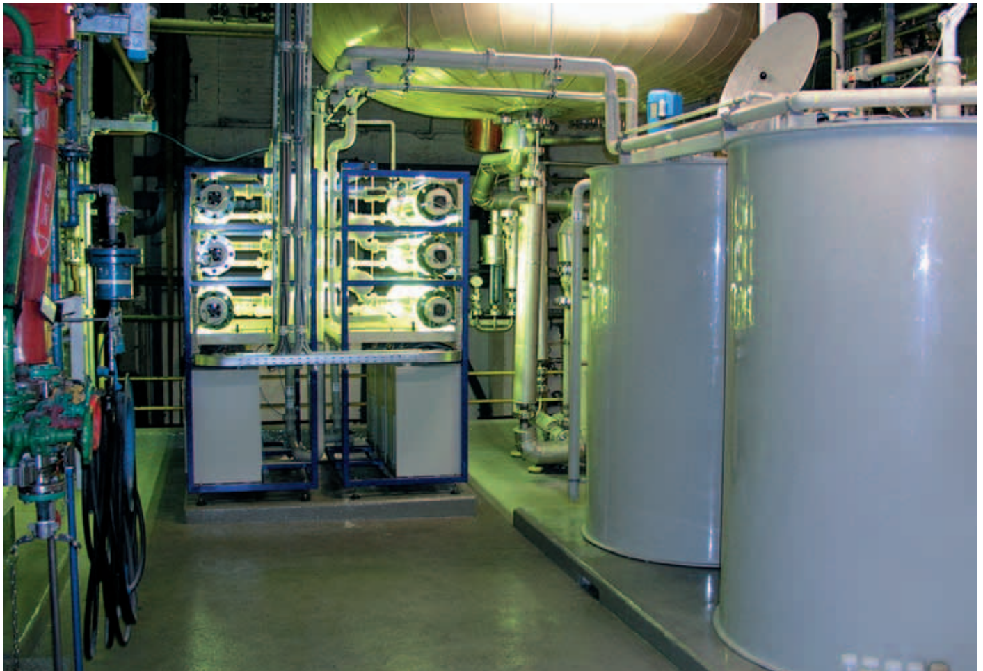
IN DER BILDMITTE DER ENVIOLET®-UV-REAKTOR, RECHTS:
